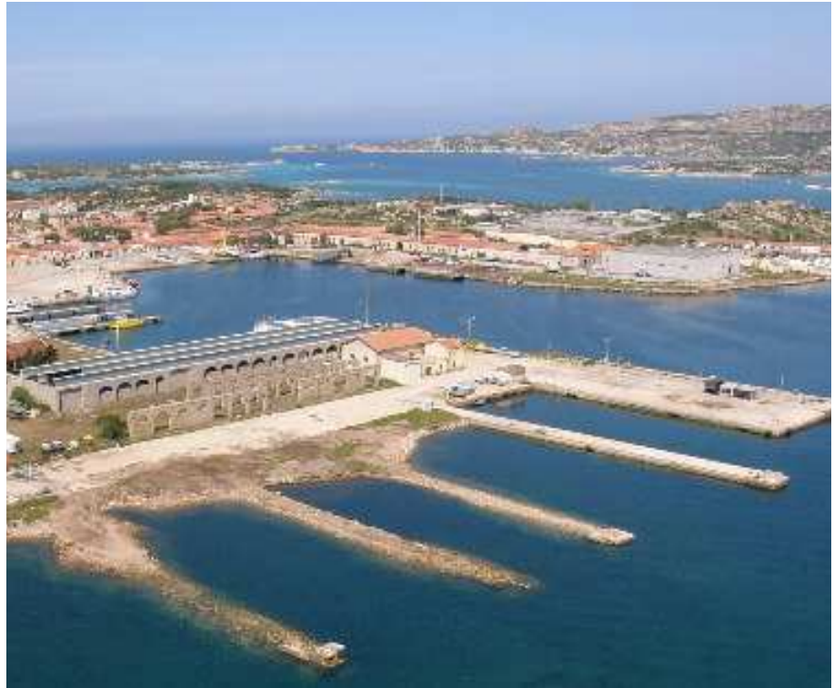
L'Arsenale della Marina Militare prima dell'intervento di riqualificazione
